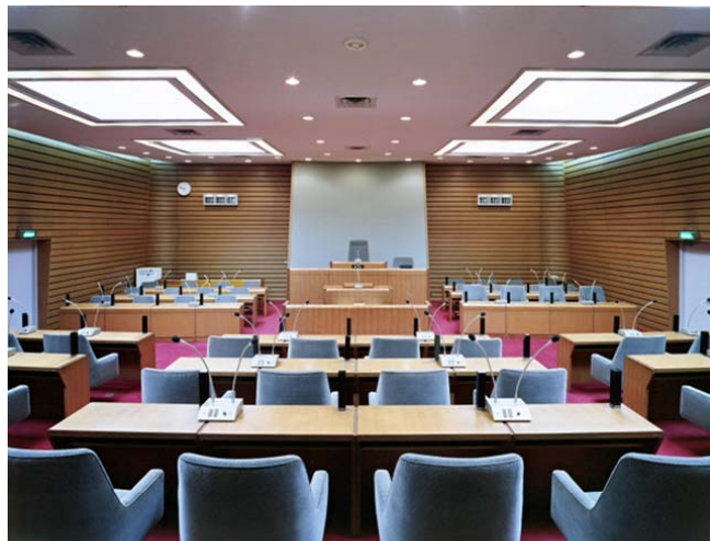
Audio 音響システム設備の設計・施工・保守
